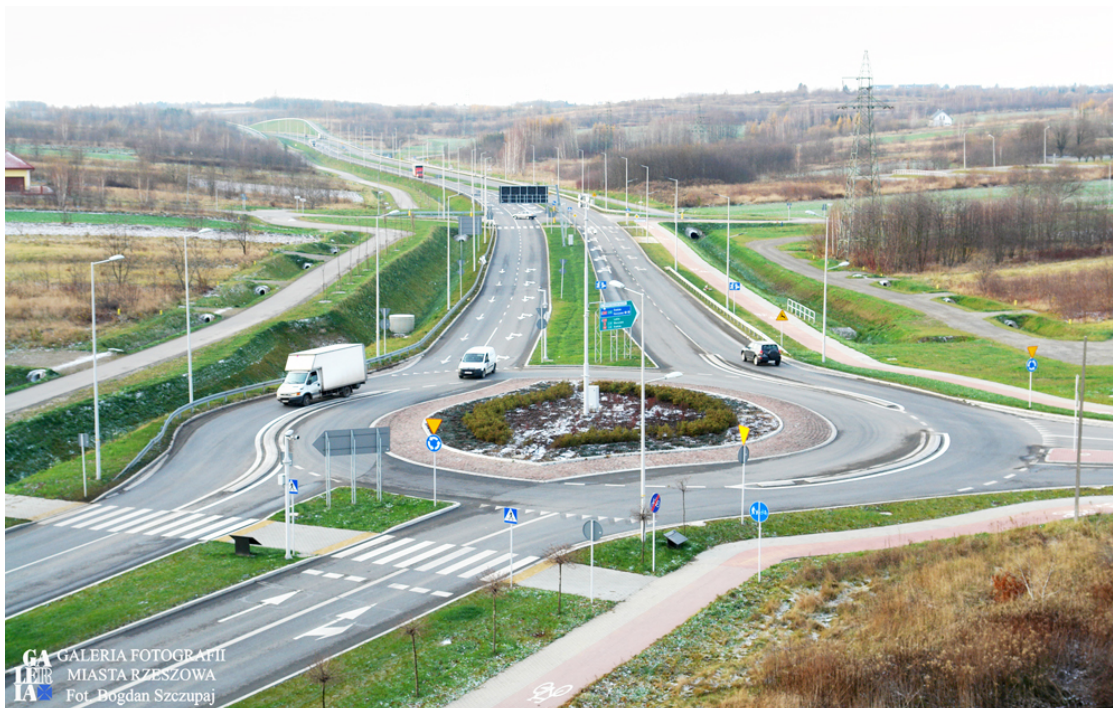
Łącznik ul. Podkarpackiej z węzłem Rzeszów Południe na drodze ekspresowej S19
