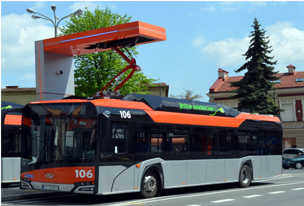
Stacja ładowania autobusów elektrycznych (przy dworcu PKP)
