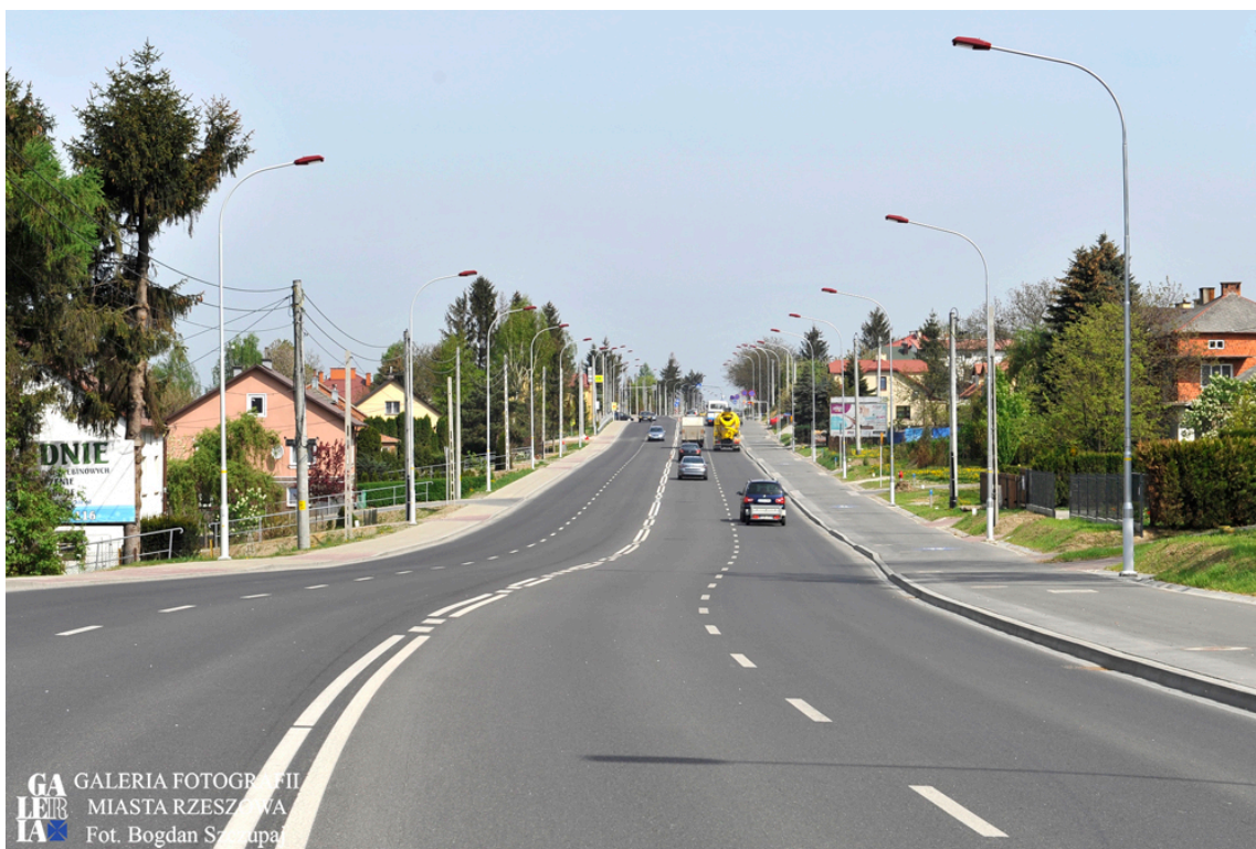
Rozbudowa Al. Gen. W. Sikorskiego
